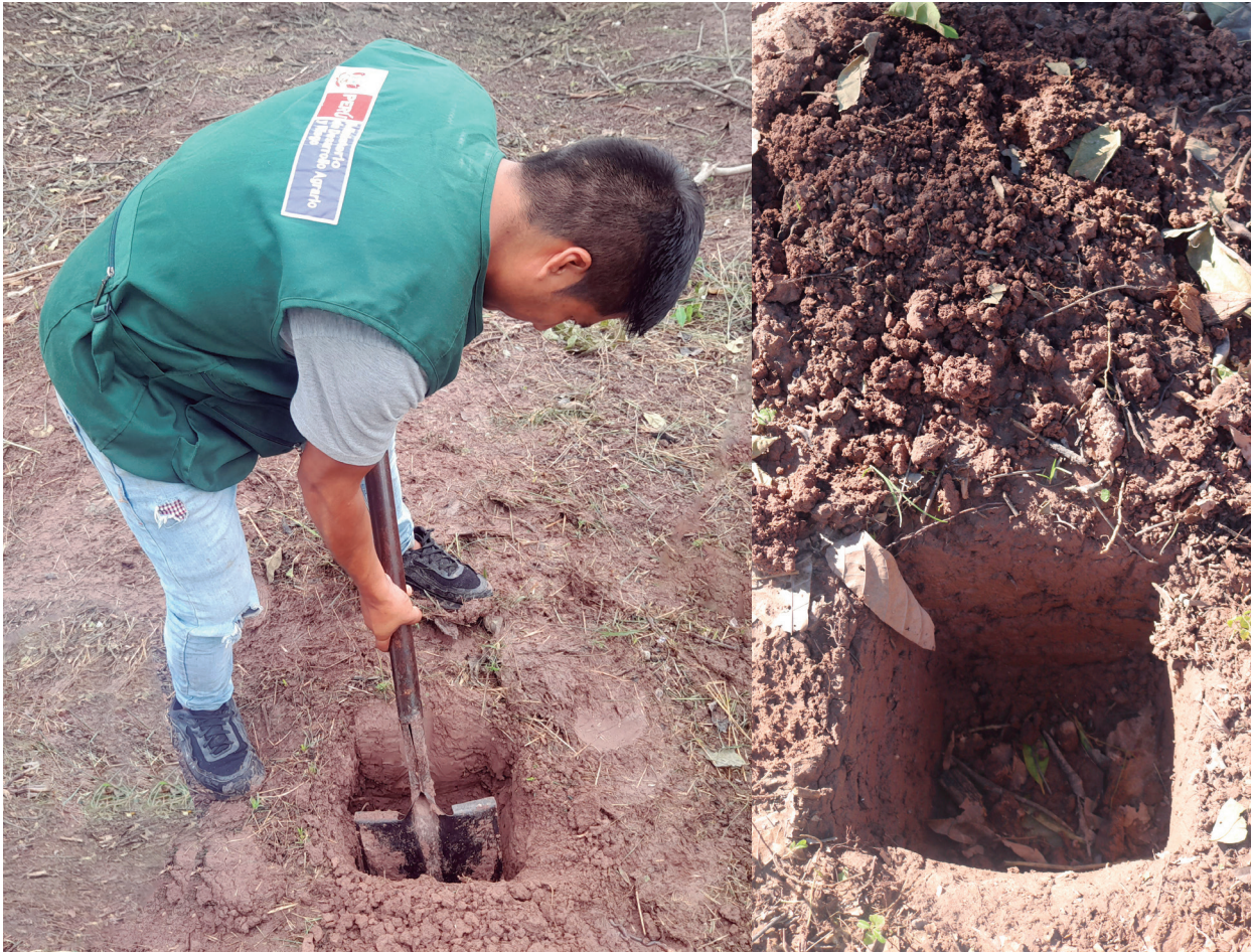
Figura 22. Apertura de hoyos
