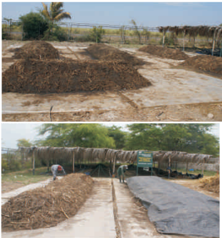
Fotos 7 y 8. Camas de compostaje “Techo a Dos Aguas” sobre losa de cemento y cubiertas con manta. Estación Experimental Agraria Vista Florida.
