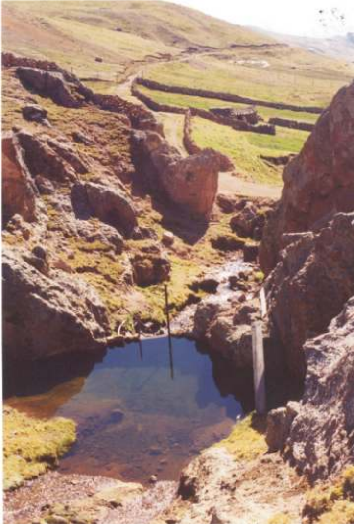
Foto 42. Represa natural para la conservación y uso de agua para riego.
