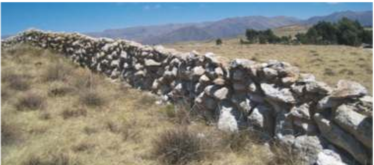
Foto 73. Cerco de piedra.
