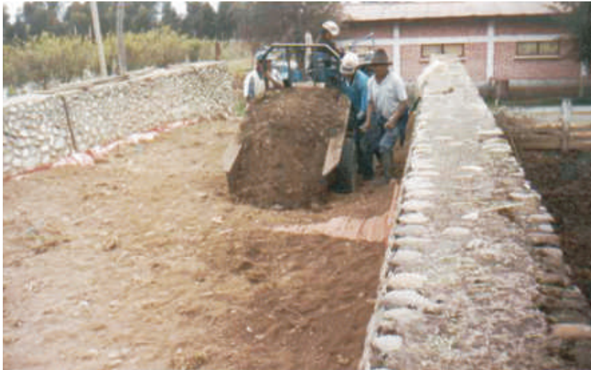
Foto 35. Tapado del silo con una capa de tierra de 30 cm, para una buena compactación.
