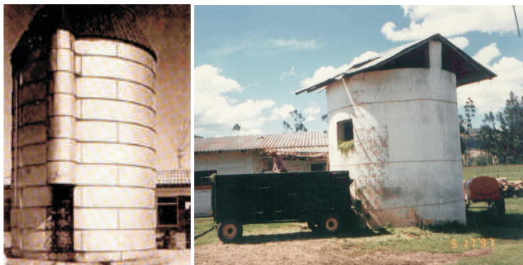
Fotos 43 y 44. Silo aéreo cilíndrico.
