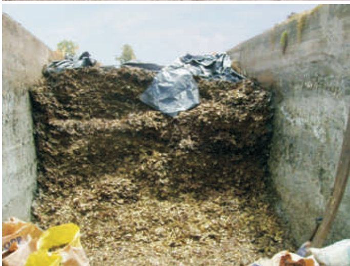
Fotos 41 y 42. Silo bunker de concreto armado, construido sobre el suelo.
