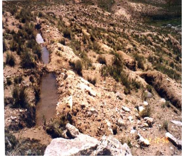
Figura 37. Zanjas de infiltración. Iscahuaca, Apurímac. MASAL 2 000 Foto R. Farfán
