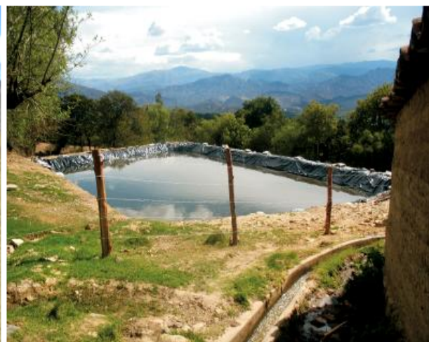
Figura 35. Captación de agua de escorrentía en piso de Valle
