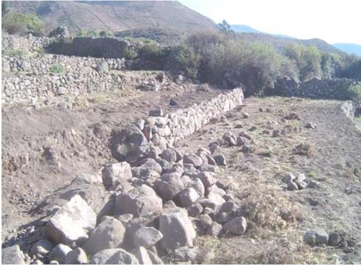
Figura 47. Rehabilitación de un andén. Tomado de Kendall. Cusichaca Trust 2005
