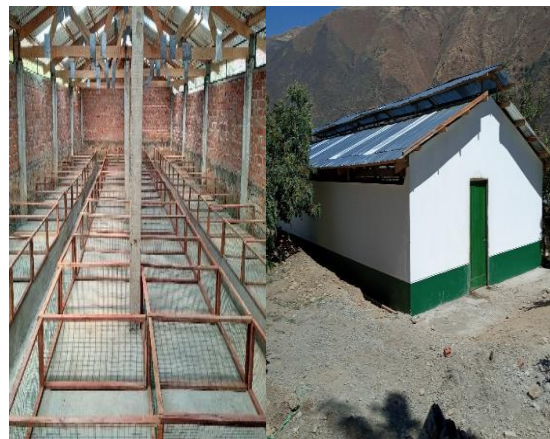
Culminación de Obra Mantenimiento y Rehabilitación de galpón de cuyes
