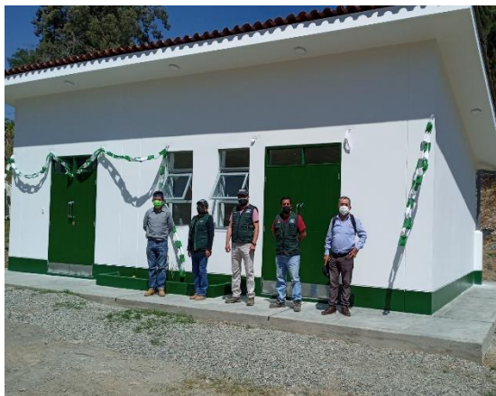
Culminación de la obra "Sala de Transferencia"
