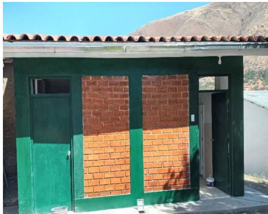
Culminación de la obra de servicios higiénicos
