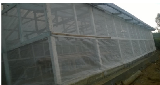
Término del invernadero, cubierto con malla antiáfida
