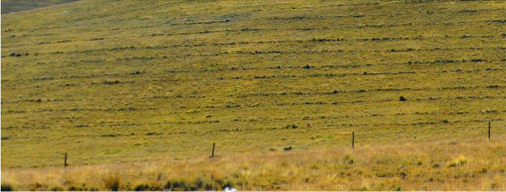
Figura 14. Zanjas de infiltración en ladera de cerro para la recuperación de la pradera nativa en laderas. Foto: Teodosio Huanca.
